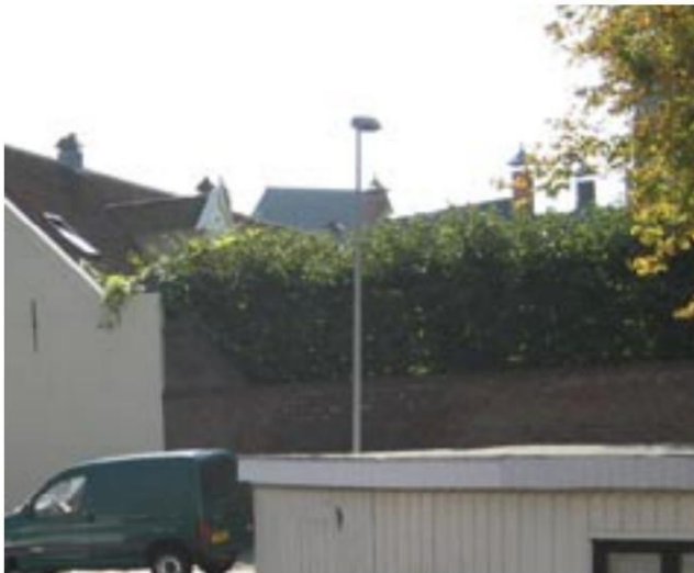
verschillende typen lichtmasten en armaturen aan de diepenring
